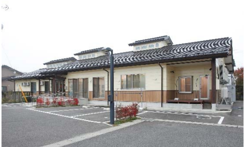
木造合金メッキ鋼板葺平家建
