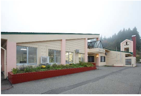
鉄筋コンクリート造亜鉛メッキ鋼板葺平家建
