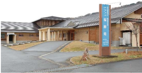
鉄筋コンクリート造亜鉛メッキ鋼板葺平家建
